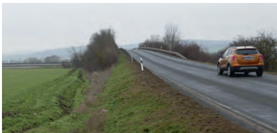
Verbindungsstraße nach Uthleben. Radweg ist linksseitig geplant. Die vorhandene und zu nutzende Unterführung folgt erst nach dem linken Bildrand.
